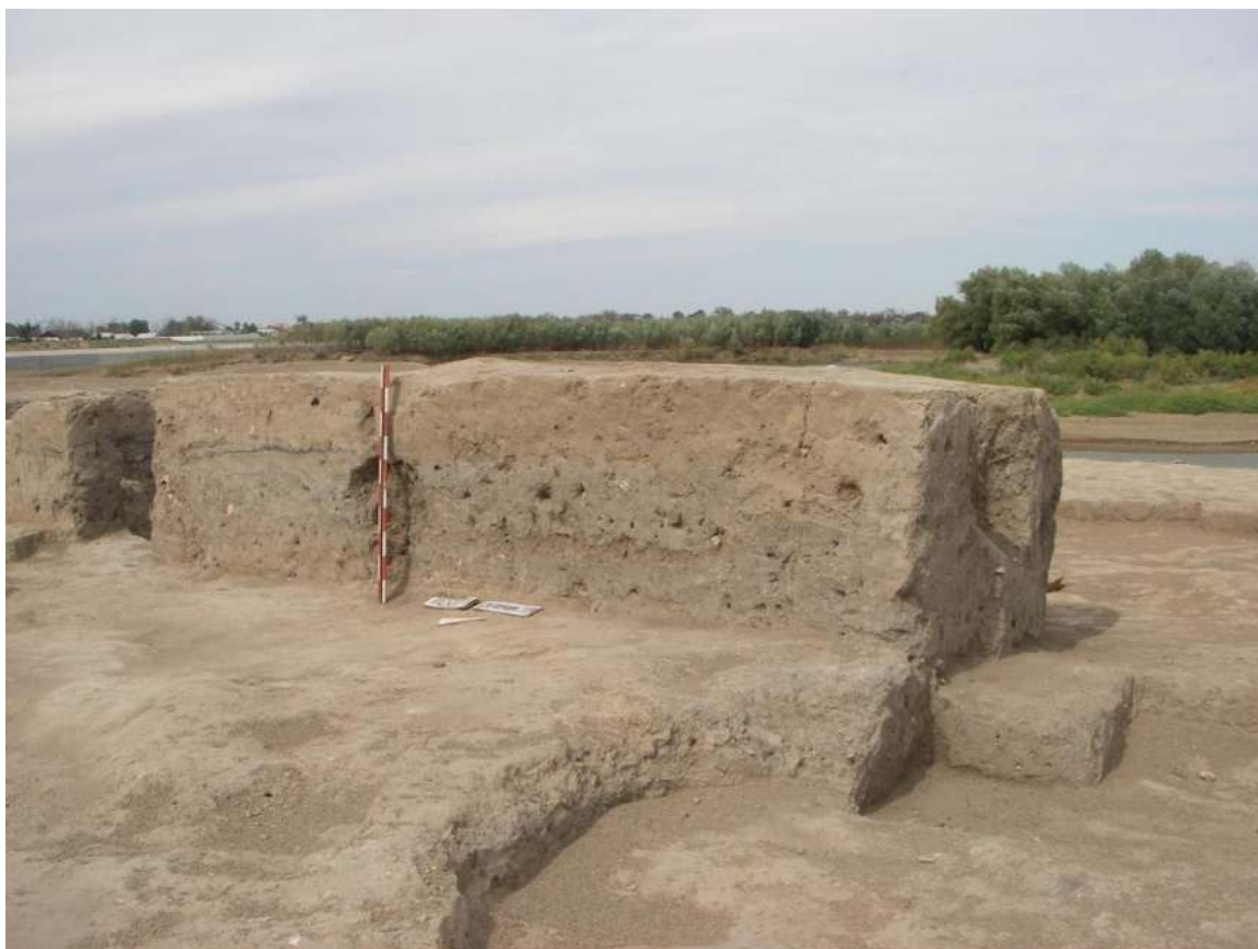
Рис. 5. Слоистое сложение низа крепостной стены.
